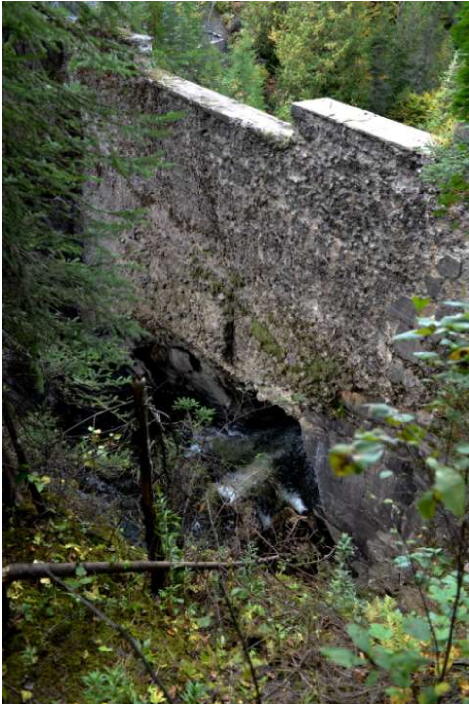
Premier barrage du parc des Chutes d'Armagh. Photo prise le 21 septembre 2013
