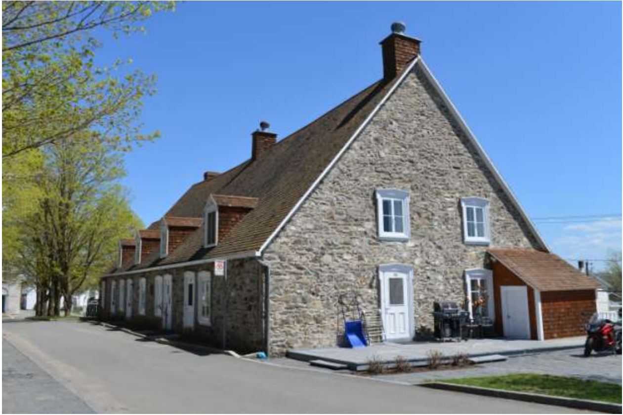
Bâtiment dont une partie a déjà servi de presbytère à la paroisse Saint-François-de-Sales. Photo prise le 8 mai 2013.
