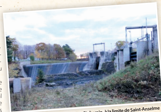
Le barrage du moulin des Abénakis, à Sainte-Claire. L'ouvrage actuel, reconstruit en béton en 1935, succède à un barrage de bois qui alimentait déjà les moulins du secteur au XIXe siècle. Source: Répertoire du patrimoine culturel du Québec et Centre d'archives de Bellechasse.
