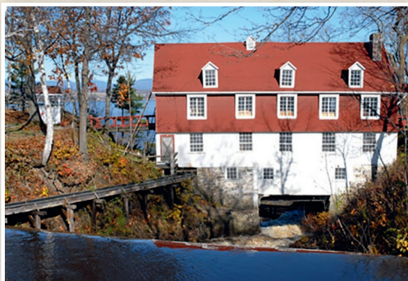
Le barrage du moulin de Beaumont, un témoin de l'époque des moulins à eau. Construit à l'origine en 1821, il fait partie du site patrimonial du Moulin-de-Beaumont. Source: Centre d'archives de Bellechasse.
