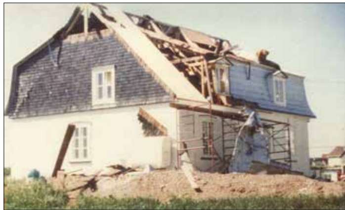
Début des travaux de restauration du Manoir seigneurial de Beaumont.
